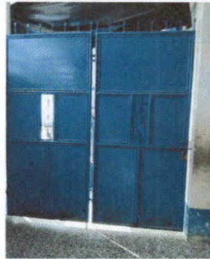
Foto 8. Mantenimiento a portones de metal.
