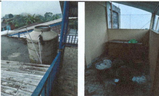
Foto 11. Sustitución de depósitos de agua.
