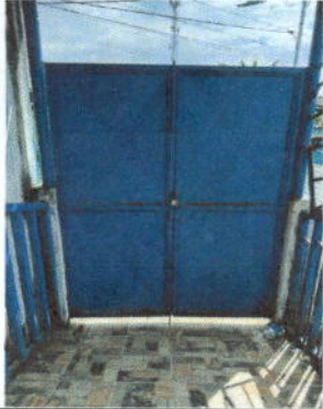
Foto 7. Mantenimiento a portones de metal.
