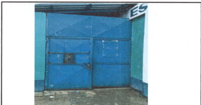
Foto 6: Mantenimiento a portones de metal.
