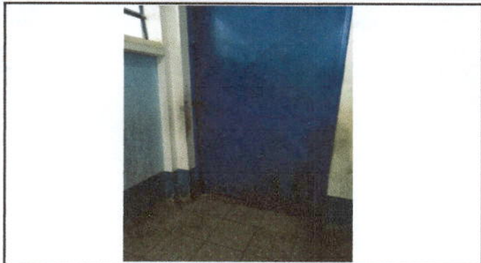
Foto 1: Mantenimiento a puertas en estructura (lijado, cambio de tubo, cepillado y sujeciones, aplicación de pintura).
