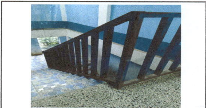
Foto 5: Mantenimiento a barandas de metal.
