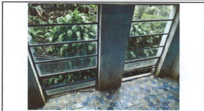
Foto 2: Mantenimiento a ventanas y sustitución de vidrios.
