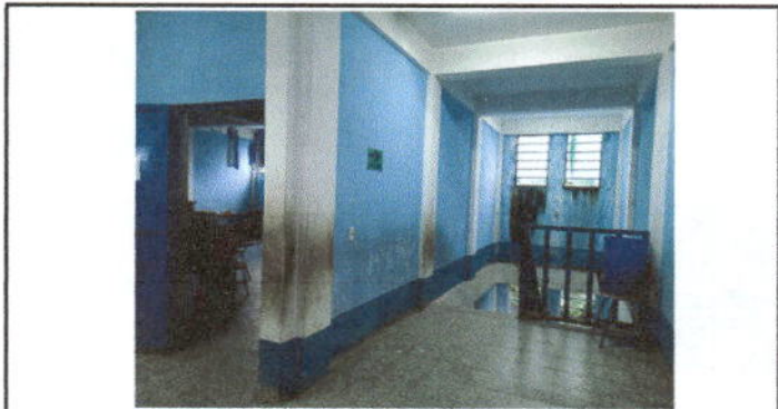
Foto 3: Pintura en muros interiores y exteriores
